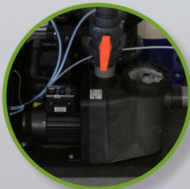
Die drehzahlgeregelte Filterumwälzpumpe hat einen wesentlich geringeren Energiebedarf als unregelte Pumpen und weniger Lärmemission.
