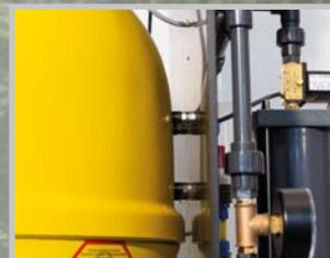
Commande de filtre multifonctions avec, entre autres, contrôle direct des pompes via convertisseur de fréquence (mode ECO).
